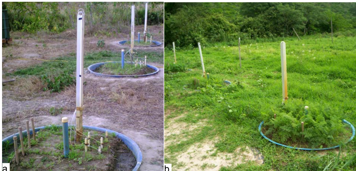
Figuras 4.12a e 4.12b – Vista parcial dos lisímetros de drenagem instalados na Fazenda Nossa Senhora do Rosário.
