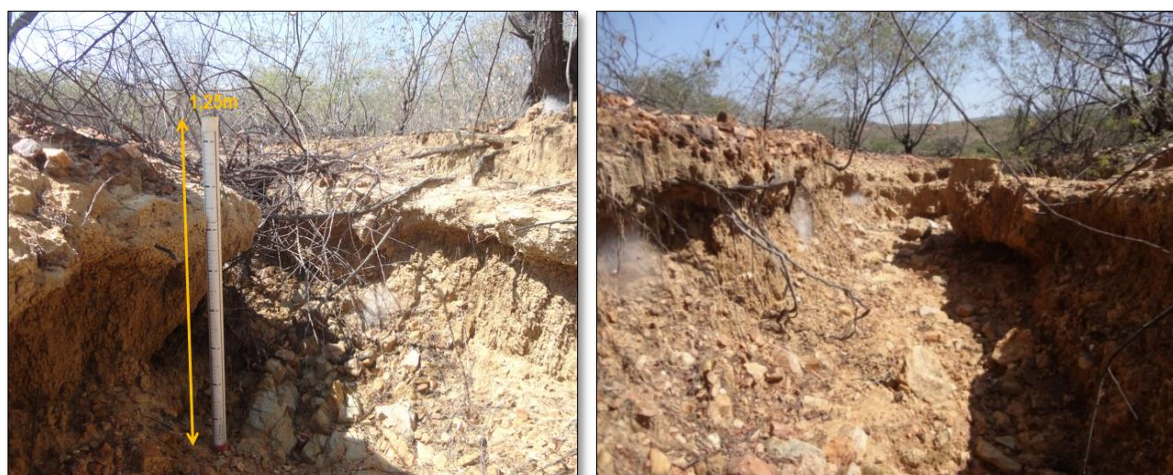
Figura 10 – Canal (I) formado na área estudada sob voçorocamento na Bacia hidrográfica do Exu
