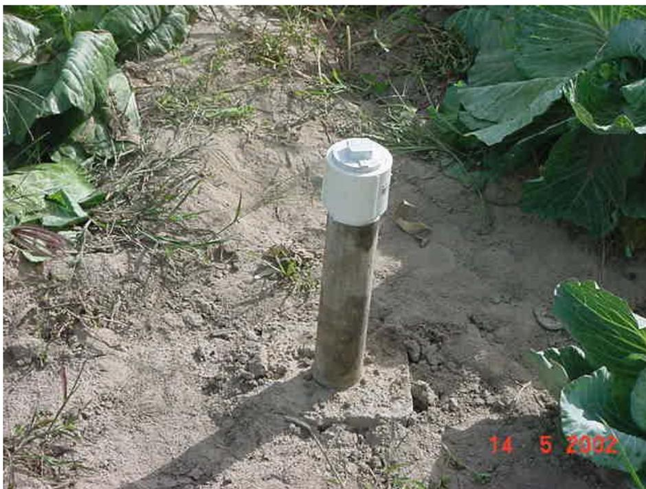
Figura 9 – Piezômetro instalado e protegido.
