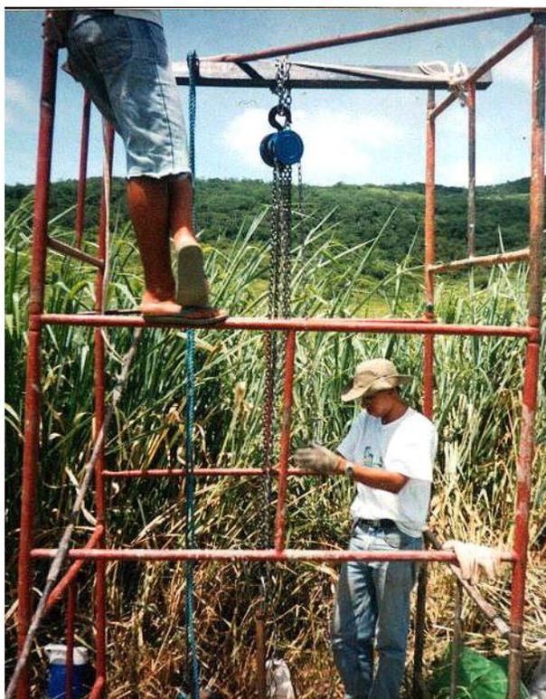
Figura 5 – Retirada do tubo de revestimento (encamisamento).
